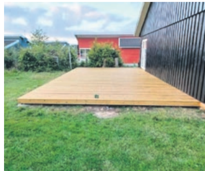
Den nye træterrasse ved Rø Medborgerhus
